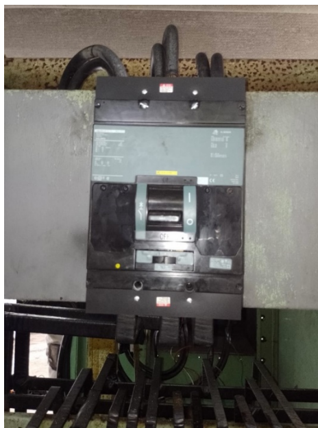
Instalado nuevo Centro de carga
