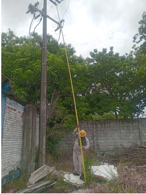
Corte de energía
