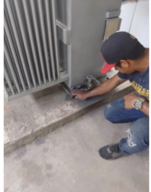
Limpieza y pintada de transformador
